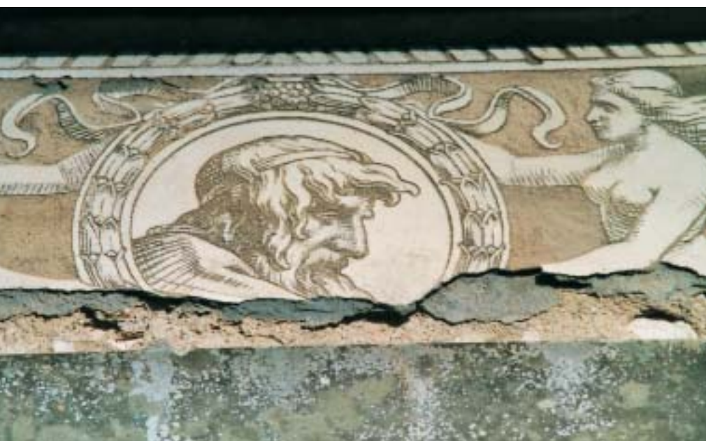
Bildausschnitt in Schadenzone über Sandsteingut aus dem Museum Zofingen AG
